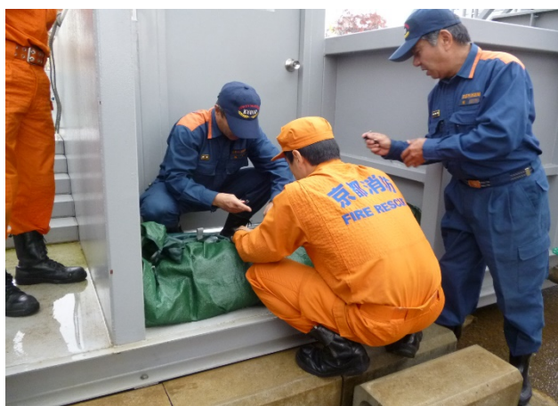
水囊壁を設置中
