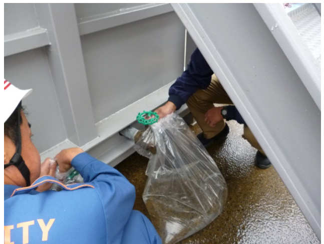
土嚢でなく水嚢をつくる作業中
